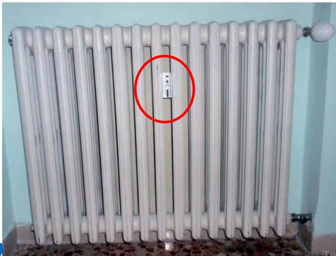
**Il progetto dell'impianto di contabilizzazione deve contenere un elenco con la «potenza nominale» ( $Kq$ ) ed il  $Kc$  di ciascun corpo scaldante**
