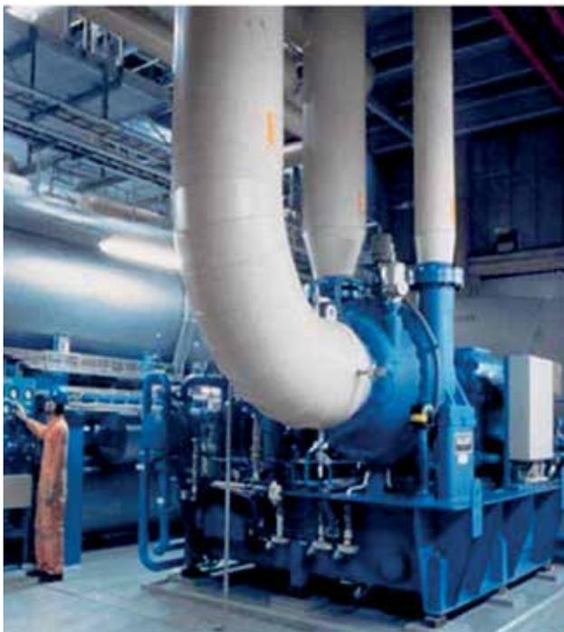
*Figura 9 – Una delle 6 pompe di calore da 30 MW della centrale di teleriscaldamento di Stoccolma (da friotherm.ch)*
