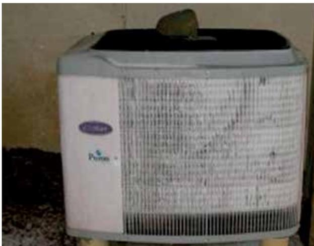
Figura 4 – Pompa di calore che necessita di sbrinamento
